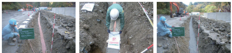
①パワーメッシュ裸銅線敷設 ②ホクデンEP-1敷設 ③敷設完了
